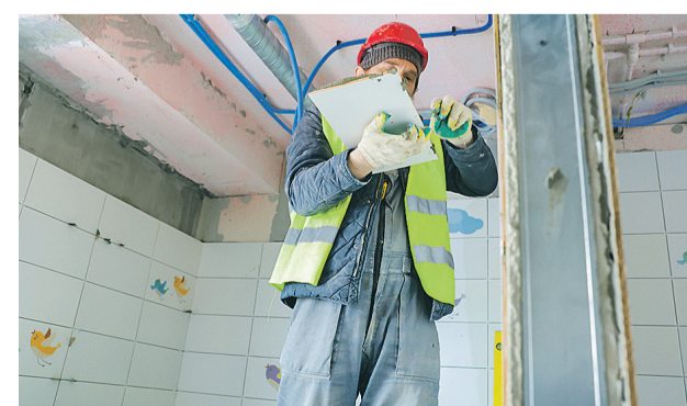
Ход капитального ремонта поликлиники № 118
