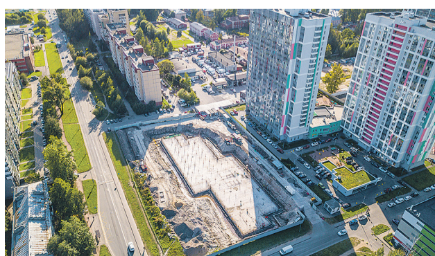
Строительство взрослой поликлиники
