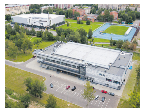
Ледовая арена на ул. Фаворского
